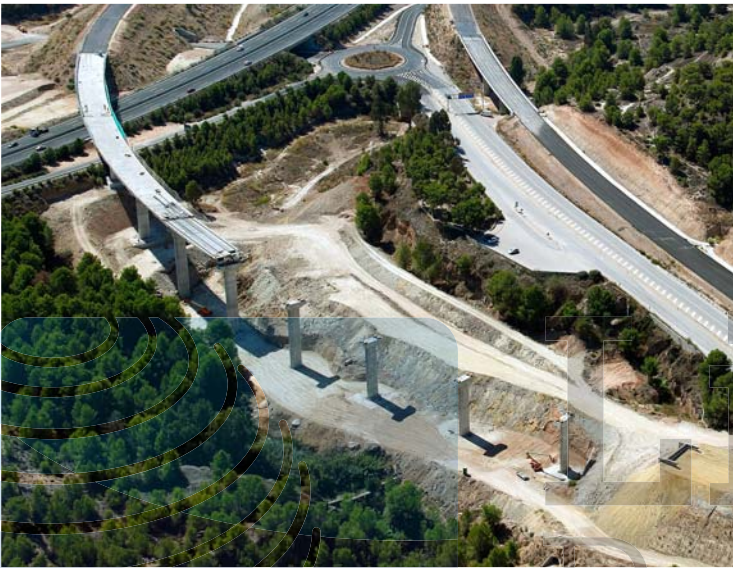
Vista general del viaducto.
